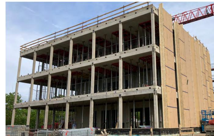
Ce système permet d'envisager des chantiers de grande envergure. Et pourquoi pas de la rénovation ? Ces murs rideaux pourraient en effet être rapportés sur le squelette de bâtiments en béton existants et ainsi assurer le recyclage de ces structures tout en accédant à des niveaux d'isolation très performants.
